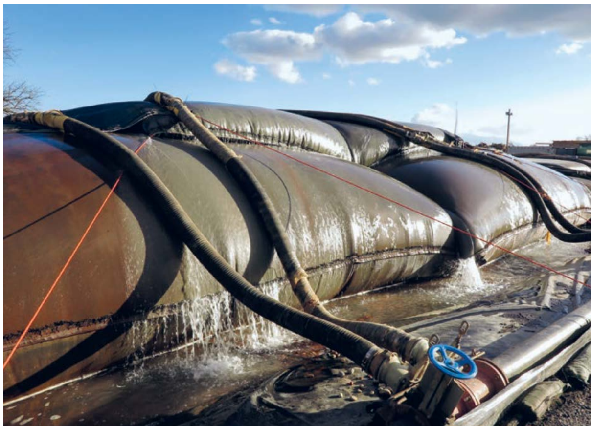
Abbildung 9: Beispiel eines Entwässerungsplatzes, auf dem Sedimente mit Geotubes entwässert werden (Foto: Umwelt Aargau, Nr. 94 Januar 2024).
