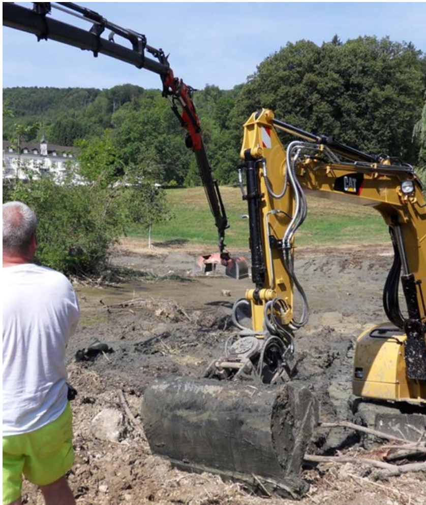
Abbildung 6: Beispiel des Ausbaggerns der Sedimente nach dem Ablassen des Wassers im Weiher bei Bad Schauenburg oberhalb Liestal (Foto: Kury, Life Science).
