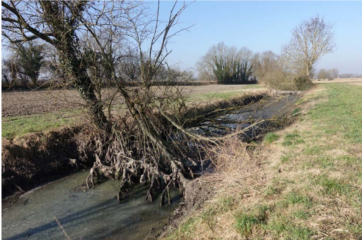
Abbildung 2: Rückstände von Entlastungsereignissen im Kanal zwischen Regenrückhaltebecken und Lachen (Februar 2023).
