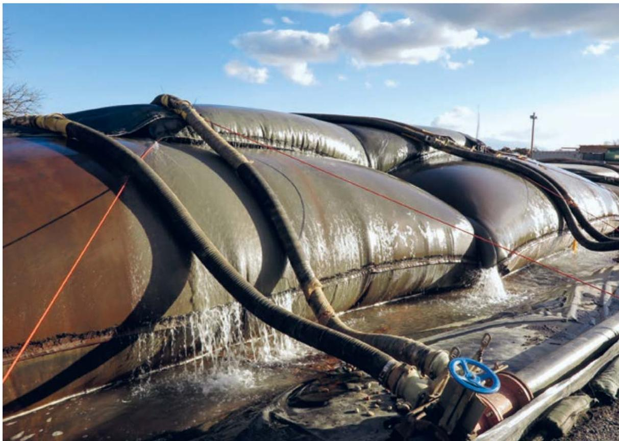
Figure 9: Exemple d'un site de drainage où les sédiments sont drainés à l'aide de géotubes (Photo : Umwelt Aargau, n° 94 janvier 2024).
